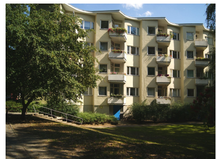
Wege zu den Wohnungseingängen sind nicht immer barrierefrei
