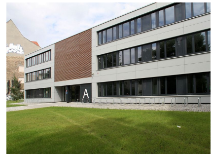
Der Modulare Ergänzungsbau an der Corinthstraße
