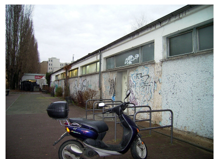
Das Funktionsgebäude vor dem Umbau
