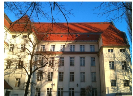
Der Nordflügel wurde neu verputzt
