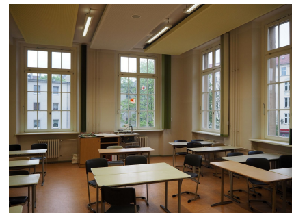
Die Innenräume erhielten unter anderem neue, denkmalgerechte, Fenster und Akustikdecken
