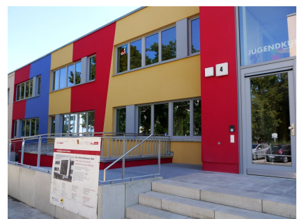
Die Jugendkunstschule wurde innen und außen umgebaut und saniert
