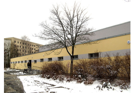
Die Fassade nach der Sanierung im März 2013
