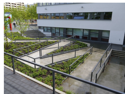
Der separate Eingang zum Bürgeramt im Souterrain
