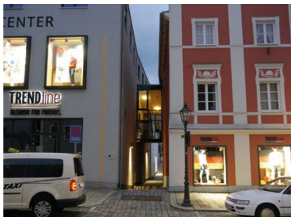
Seltene Kooperation von Eigentümern und Händlern: Die Verbindung von zwei Bestandsgebäuden zu einer Galerie. Quelle: Bundestransferstelle
