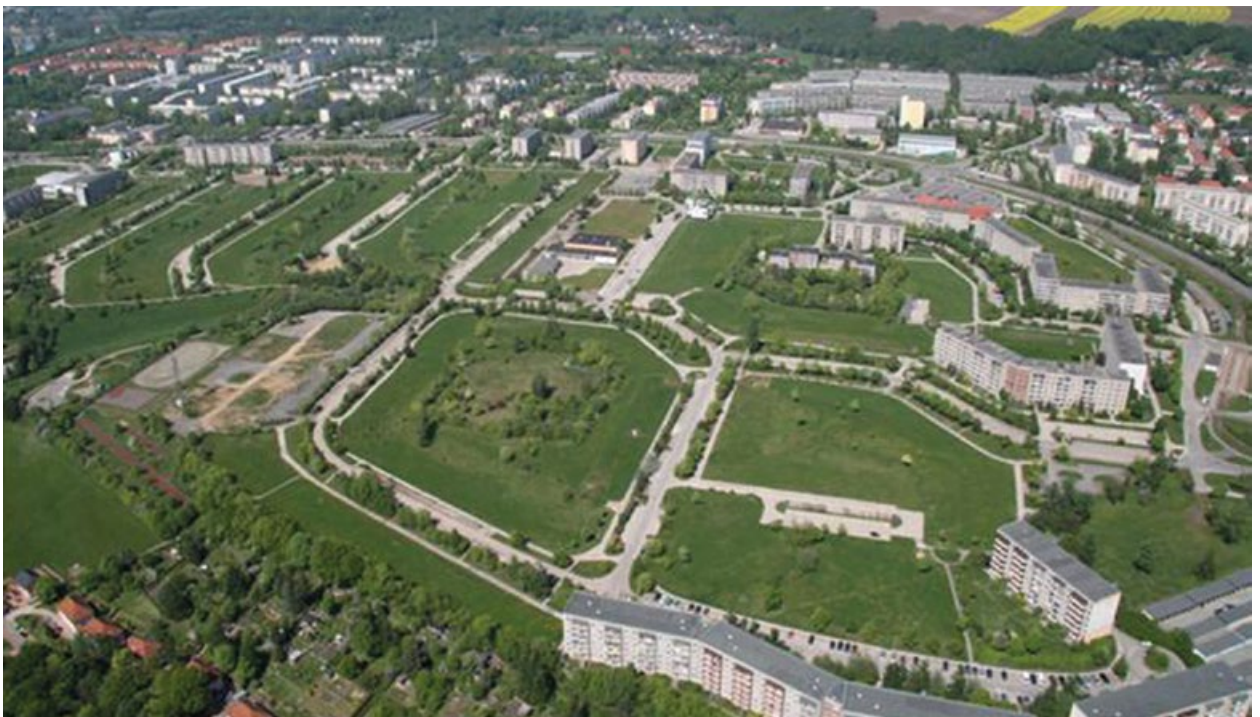
Luftbild nach Teilrückbau und Sanierung Quelle: Gebäude- und Grundstücksgesellschaft Zwickau mbH (GGZ)
