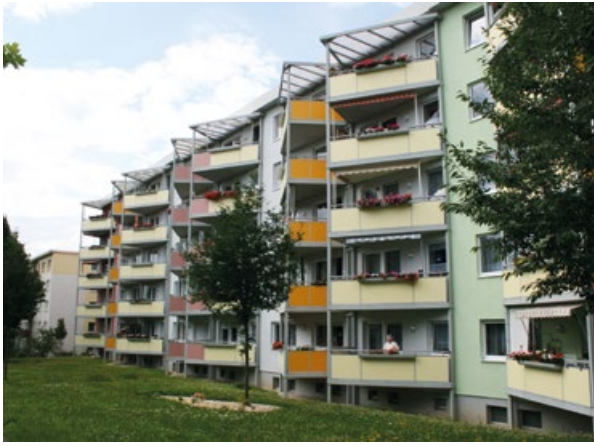
Seniorenwohnheim »Service Wohn Park«, Quelle: Bundestransferstelle
