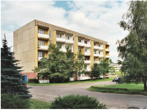
Wohngebäude vor dem aufwendigen Umbau. Quelle: Jean-Luc Valentin, Forster Architekten
