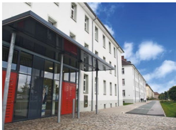
Ehemalige Kasernengebäude werden nach Sanierung heute vom Finanzamt genutzt. Quelle: Bundestransferstelle
