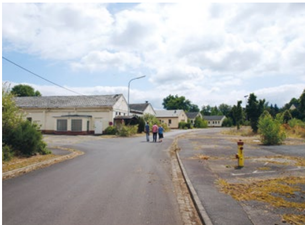
Das Areal heute. Quelle: Bundestransferstelle
