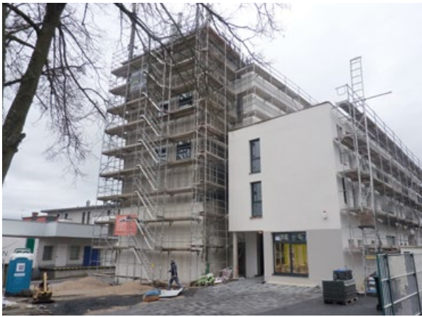
Der östliche Ortskern hat eine solche Anziehungskraft entfaltet, dass ein Bestandsgebäude saniert und mit einem Wohnungsanbau versehen wurde. Quelle: Bundestransferstelle
