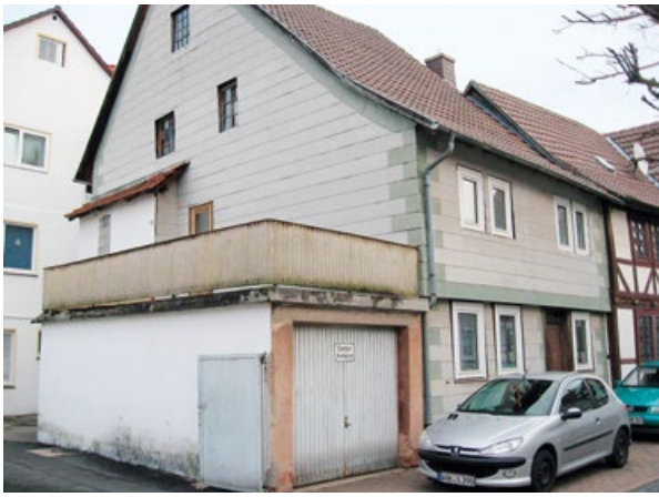
Fachwerkmusterhaus vor der Sanierung Quelle: Bürgergruppe Wanfried
