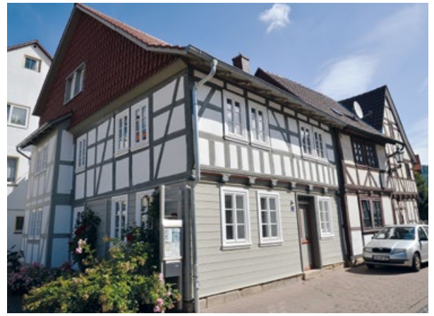
Fachwerkmusterhaus nach der Sanierung Quelle: Bürgergruppe Wanfried
