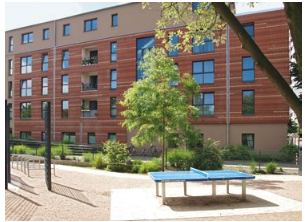
Der Hof der neu gebauten Louise-Schröder-Schule wurde u. a. mit Stadtumbaumitteln gestaltet. Quelle: Bundestransferstelle
