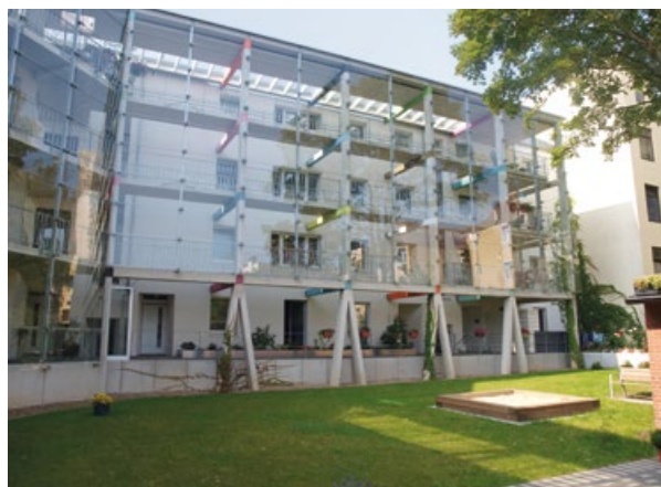
Im Ortsteil Klushof befindet sich auch der preisgekrönte Umbau einer Wohnanlage aus den 1950er Jahren. Quelle: Bundestransferstelle
