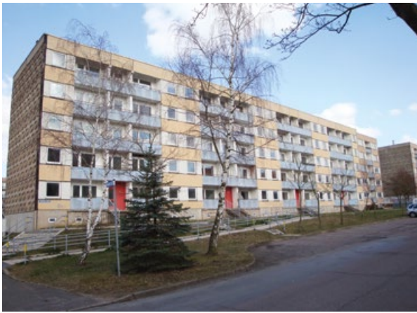
Wohngebäude Wuppertaler Straße 22 – 24 vor der Sanierung. Quelle: Schweriner Wohnungsbaugenossenschaft eG
