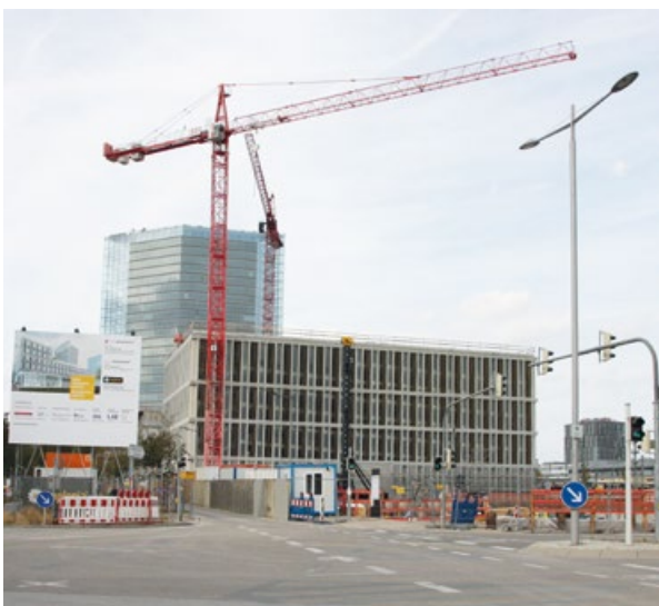
Baufortschritt im Glückstein-Quartier (Sommer 2018). Quelle: Presse-Büro Warlich im Auftrag der Stadt Mannheim
