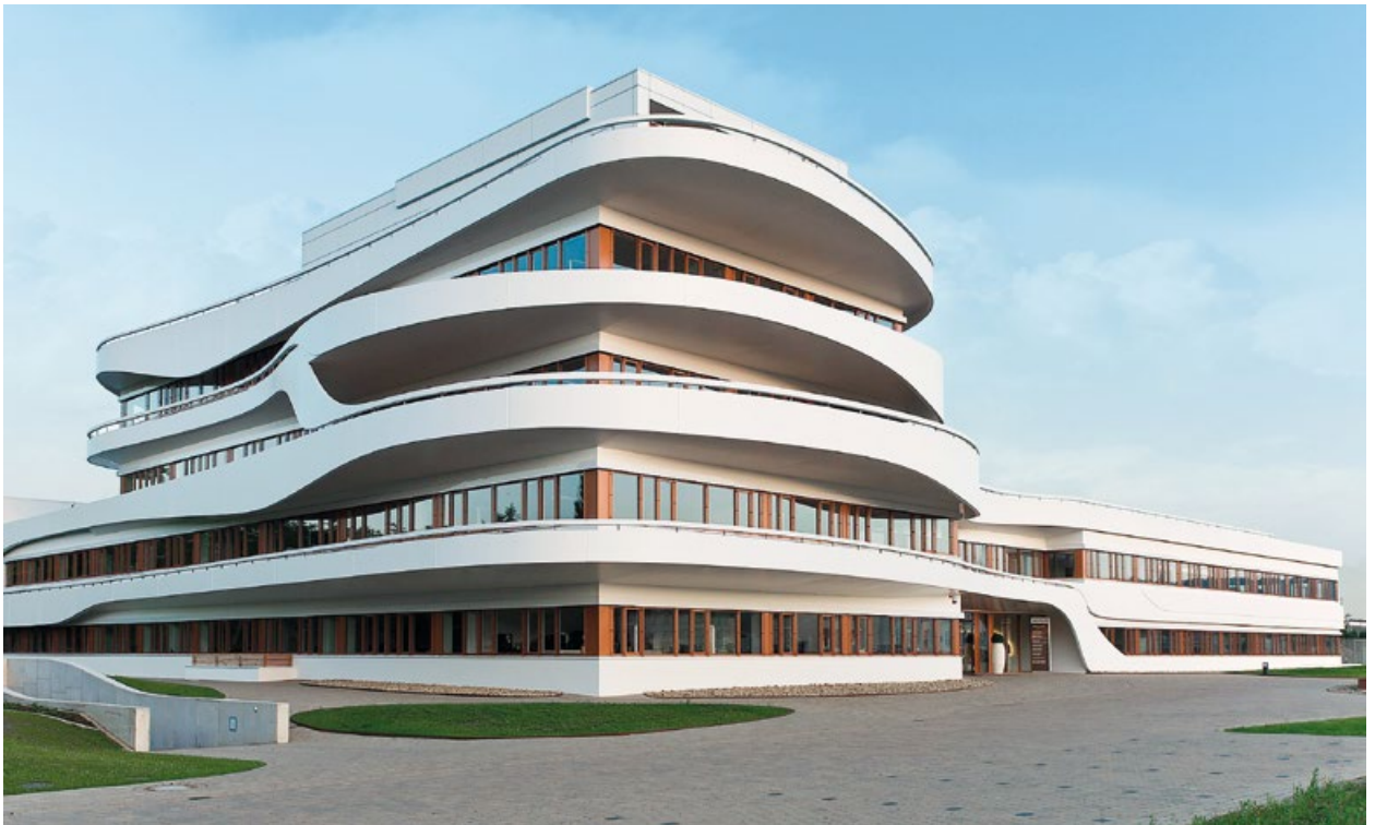
Im Konversionsgebiet »Hafen« konnten auch neue Dienstleistungsunternehmen mit Neubauten angesiedelt werden. Quelle: Sören Münzer, Trancerapid Photography
