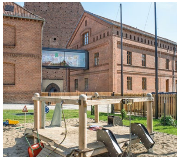
Für die neue Integrationskita wurden zwei Altbauten miteinander verbunden. Quelle: Bundestransferstelle
