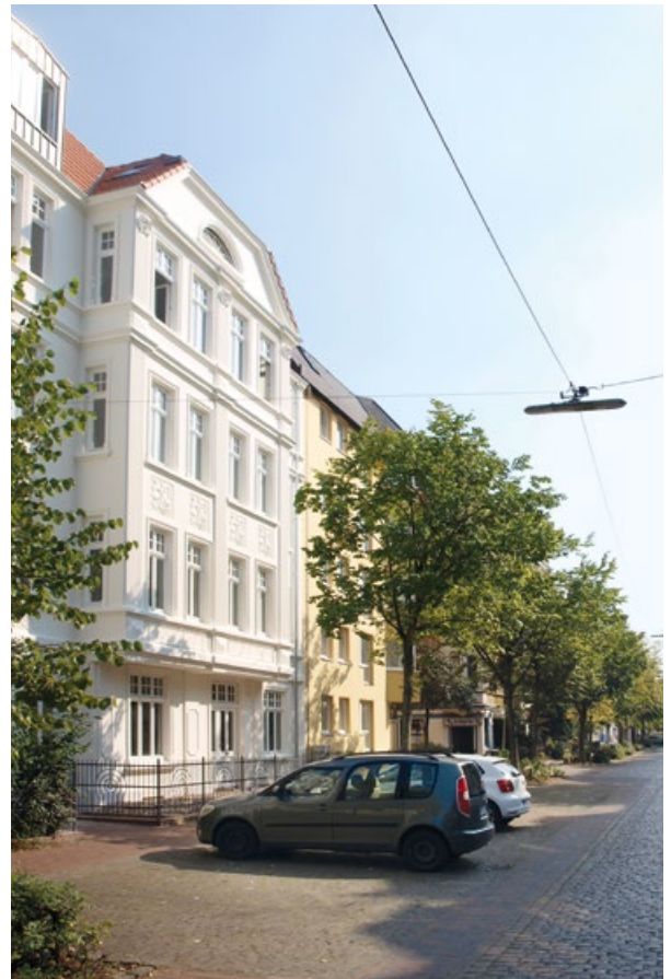
In der Goethestraße werden zurzeit ehemalige »Schrottimmobilien« von einem privaten Investor saniert. Quelle: Bundestransferstelle
