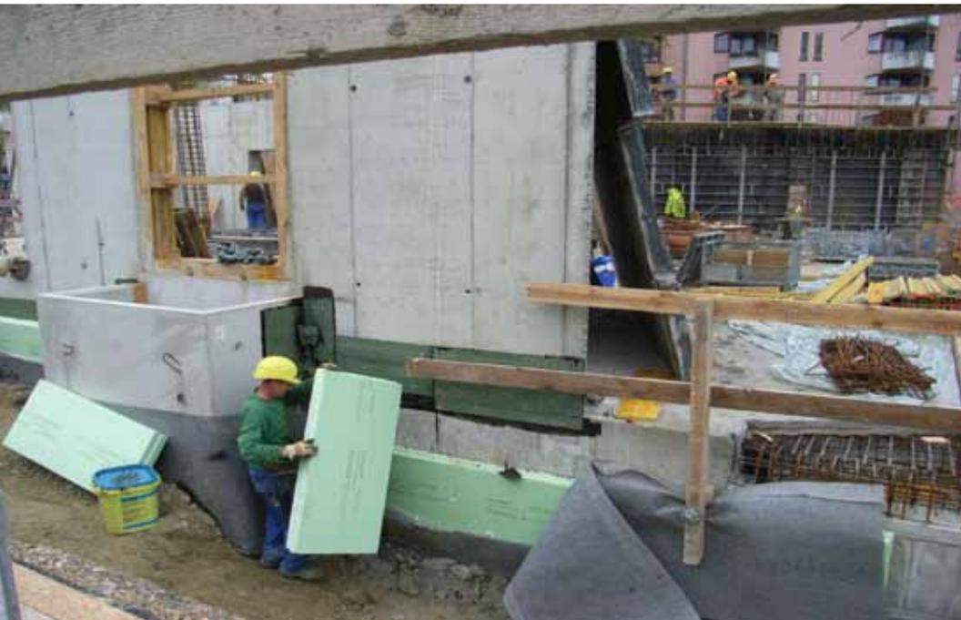
Einsatz von Wärmedämmung im Wohnungsneubau
