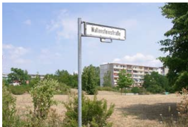
Rückbauflächen im Wohngebiet Neuberresinchen in Frankfurt (Oder)
