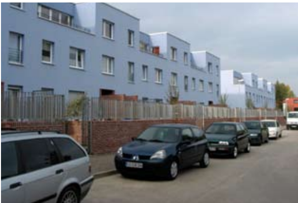
Teilrückbau und Umbau von Plattenbauten in Leinefelde
