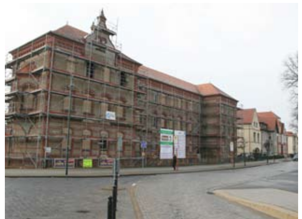
„Hier entstehen altengerechte Wohnungen mit Betreuungsangebot“ – Sanierung einer großen Einzelimmobilie durch ein Wohnungsunternehmen in Neustrelitz
