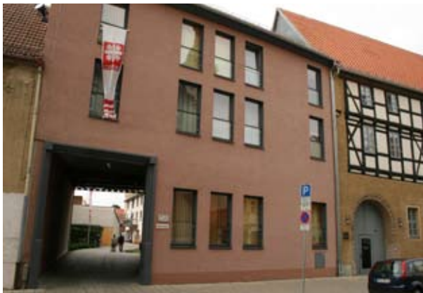
Pflegeheim der Caritas in der Altstadt von Aschersleben, das einen sanierten Altbau, eine Lückenschließung und einen Neubau im Hof umfasst.
