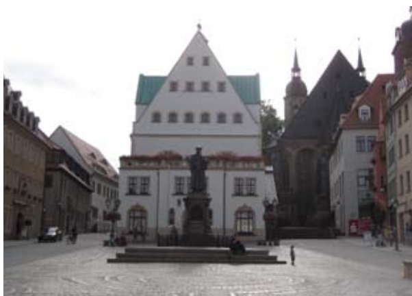
Saniertes Einzeldenkmal in der Lutherstadt Eisleben
