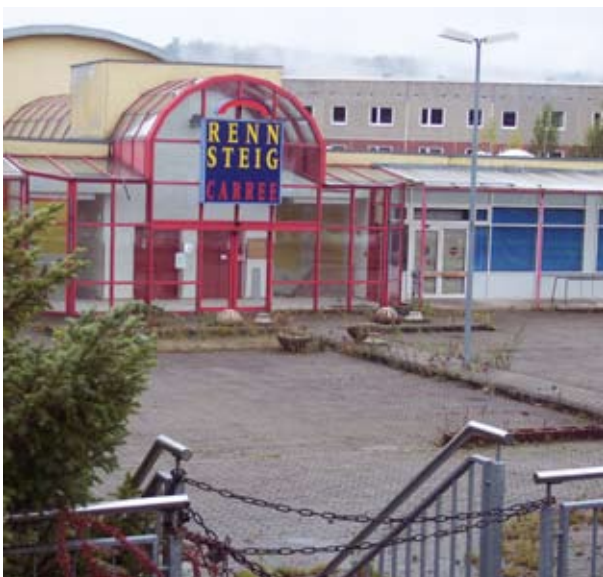
Das in den 1990er Jahren errichtete Einkaufszentrum ist inzwischen geschlossen.
