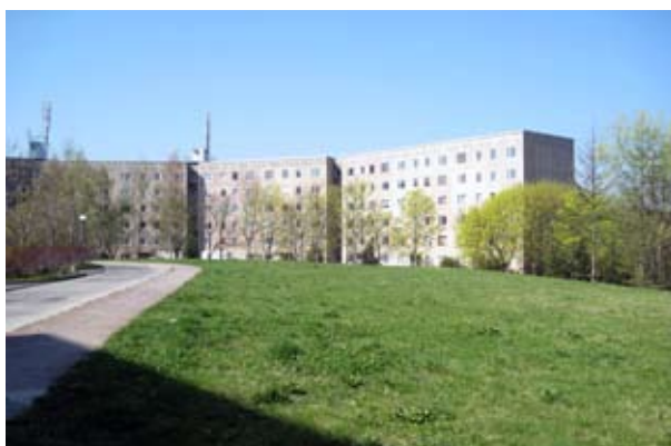
Rasensaat auf Rückbauflächen
