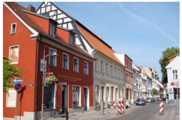
Privatfinanzierte Sanierung von Wohngebäuden in der historischen Altstadt von Ueckermünde
