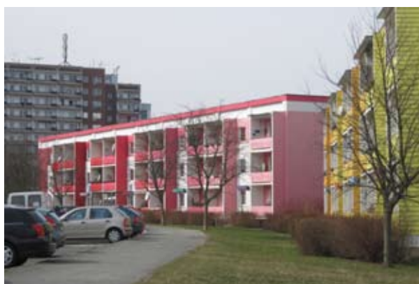
Einfacher Teilrückbau durch Geschossreduzierung
