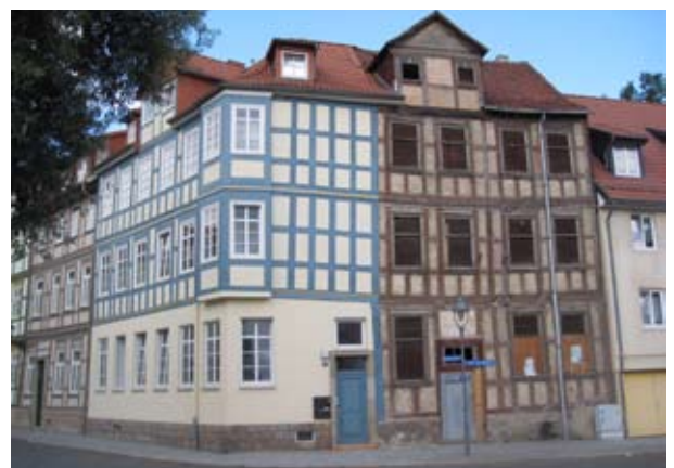
Sanierte und unsanierte Wohngebäude im historischen Stadtkern von Halberstadt
