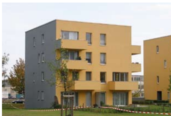
Teilrückbau von Plattenbauten zu Stadtvillen in Leinefelde-Worbis: Realisierungswettbewerbe sicherten eine hohe Qualität der Umbauten.
