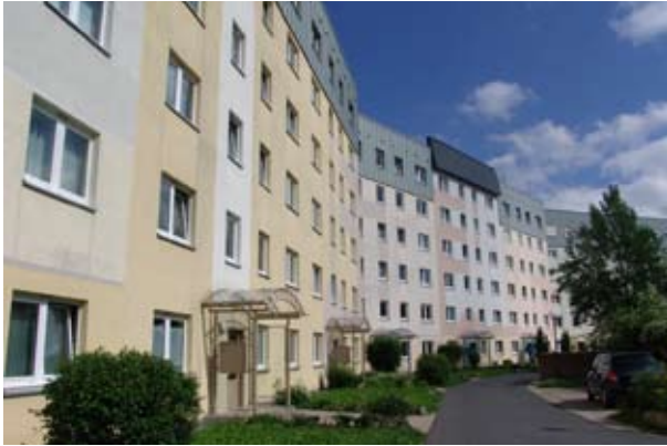
Sanierte Wohngebäude in Suhl-Nord erschweren einen flächenhaften Abriss.
