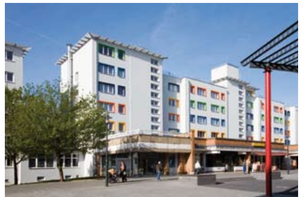
Seniorenpflegeheim und altengerechte Wohnanlage an den Ringkolonnaden nach Teilrückbau eines elfgeschossigen Wohngebäudes
