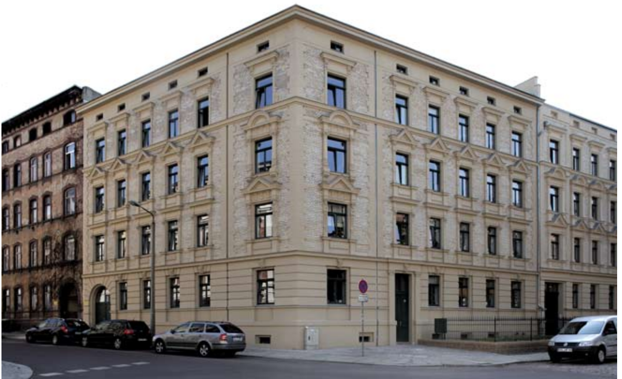
In Halle-Glauchau hat der Einsatz von Sicherungsmitteln aus dem Programm Stadtumbau Ost viele Sanierungen angestoßen.
