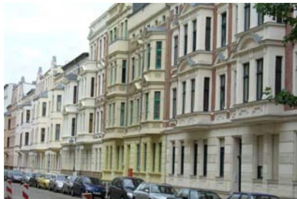
Ein großer Teil der Gründerzeitbestände in Magdeburg-Stadtfeld wurde in den 1990er Jahren saniert.
