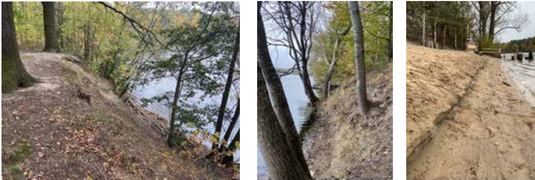
Abb. 32: Uferbereiche mit Absturzgefahren, mit Gefahren von Böschungs-rutschungen oder von Kliffbildung (2021), CDM Smith)
