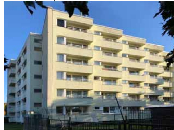
Domizil, Blick von Süden
