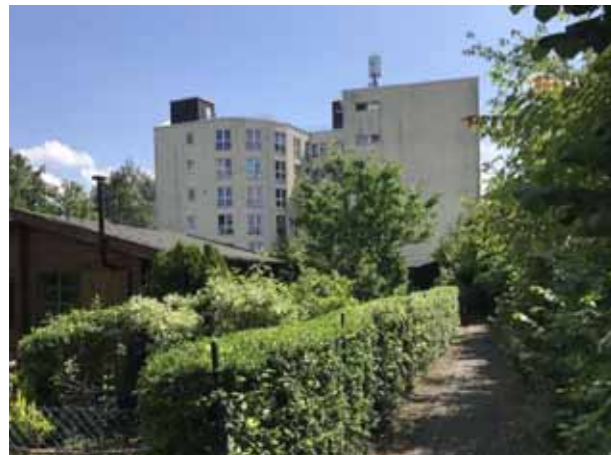
Domizil, Blick von Norden, Zufahrt von der Götzstraße entlang KGA ‚Friede und Arbeit‘ (links)
