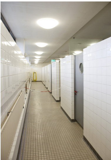
Abb. 41 - Stadtbad TH / Umkleidebereich
