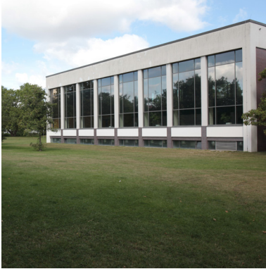
Abb. 106 - Stadtbad Tempelhof / Südansicht Schwimmhalle
