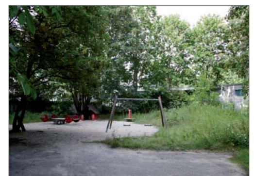
Erneuerungsbedarf in Grünanlagen: Instandsetzung, Aufwertung, Zugänglichkeit, Vernetzung (hier: hinter der Bibliothek)
