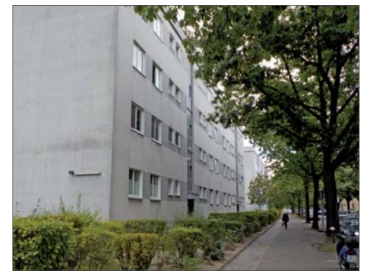
Energetischer Erneuerungsbedarf (hier: Bau an der Felixstraße)
