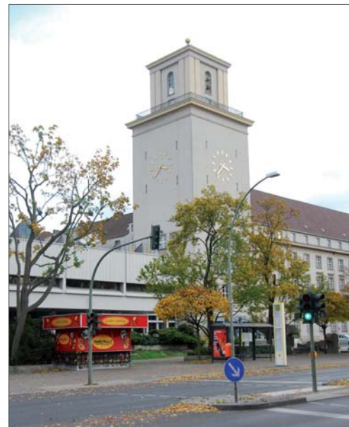
Rathaus Tempelhof, entstanden in den Jahren 1937-38, links der 1969 errichtete BVV-Saal
