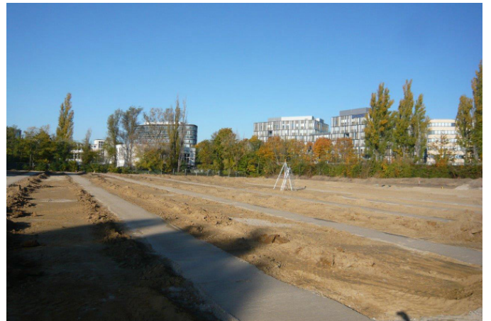
Drainagebahnen für die Wasserableitung für die Wasserableitung
