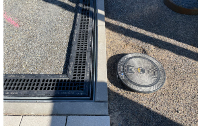
Rinnen zur Filterung von Kunststoffpartikeln
