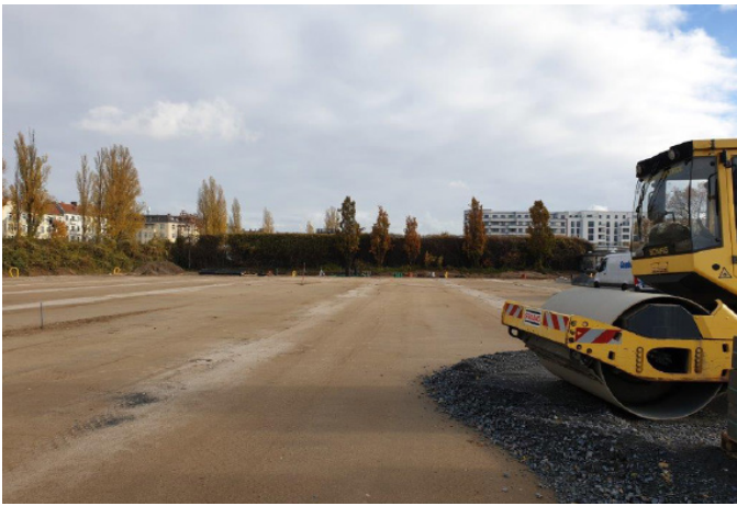
Der Natursteinschotter wird auf dem Platz eingeebnet
