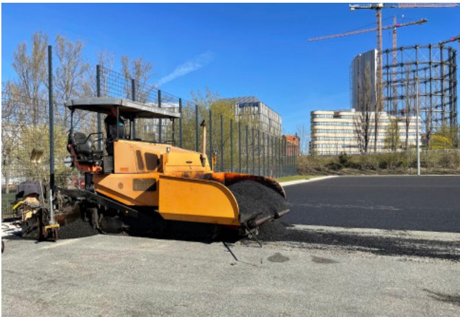
Die elastische Tragschicht als Basis für den Kunstrasen wird aufgetragen
