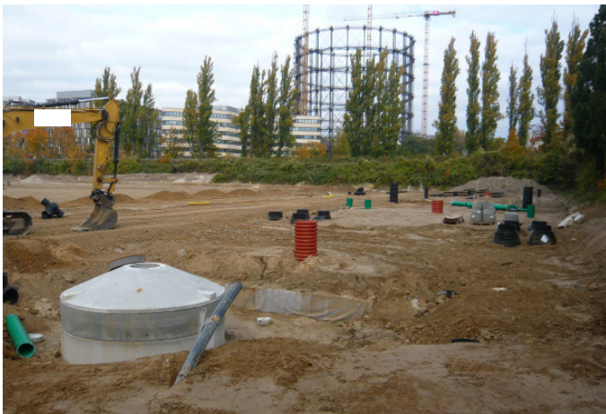
Baustellenfoto: Erdarbeiten mit Rigolen und Zisterne für das Wassermanagement
