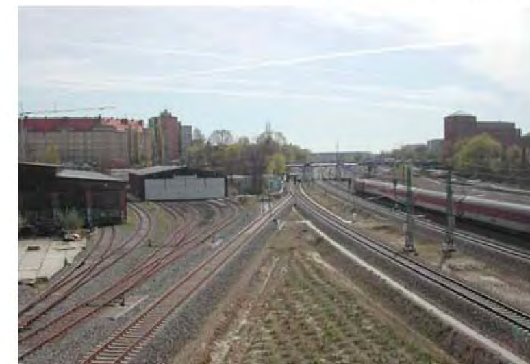
Gleisanlagen am Flaschenhals
