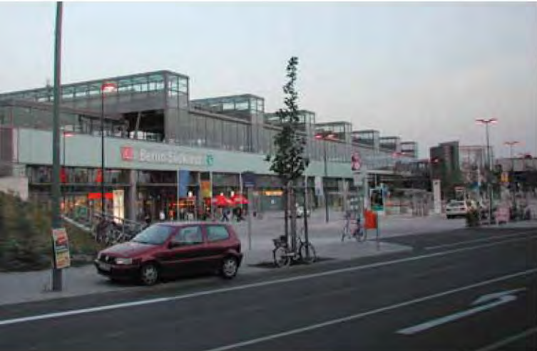
Bahnhof Südkreuz: Zugang von Westen
