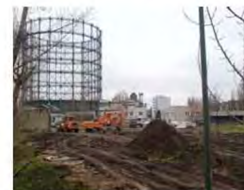
Bauarbeiten Gasag Nordspitze
