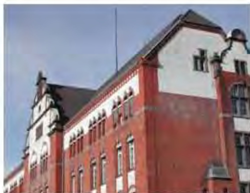
C. Ehemalige Kasernengebäude
