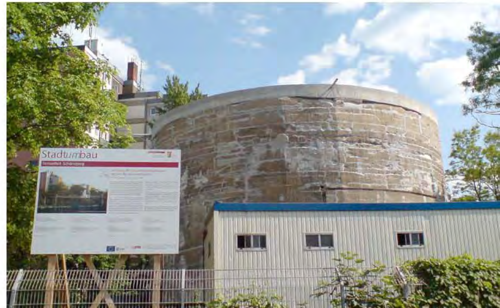
Sanierung des Schwerbelastungskörpers
