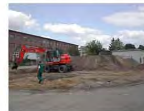
Erste Baumaßnahmen Naumannstraße
