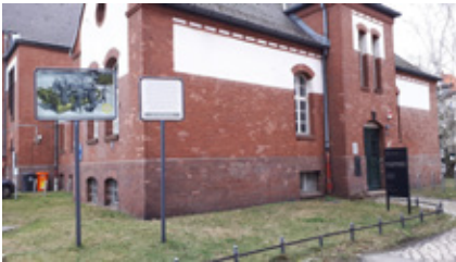
General-Pape-Straße, Eingang Haus 54a Foto: roedig . schop architekten, 2018
