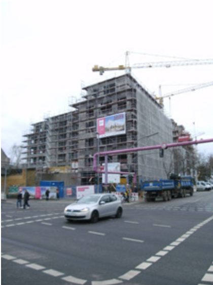
Baustelle „Stadtquartier Bautzener Straße“ Foto: roedig . schop architekten, 2018
