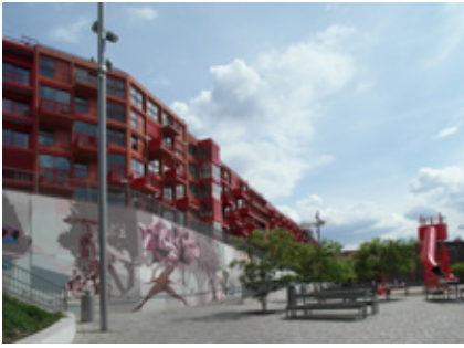
Wohnbebauung und Spielplatz „Am Lokdepot“ Foto: roedig . schop architekten, 2016
