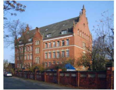
Gebäude der Gewerbe- und Kulturkaserne General-Pape-Straße Foto: roedig . schop architekten, 2009
