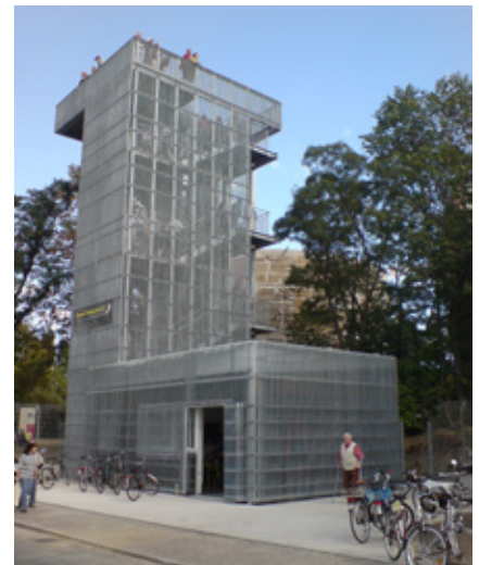
Schwerbelastungskörper und Aussichtsturm / Infopavillon
