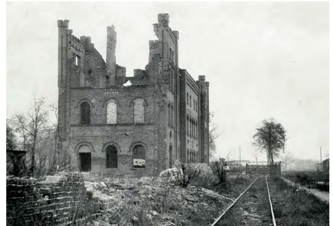
Ruine des Schöneberger Bahnhofsgebäudes kurz vor dem Abriss 1955
