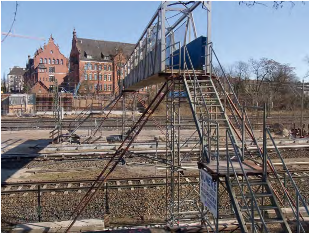
Arbeitsbrücke beim Bau des Alfred-Lion-Stegs, 19.3.2011
