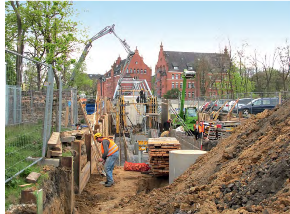
Bau der Fundamente für die Rampe zum Alfred-Lion-Steig, April 2012
