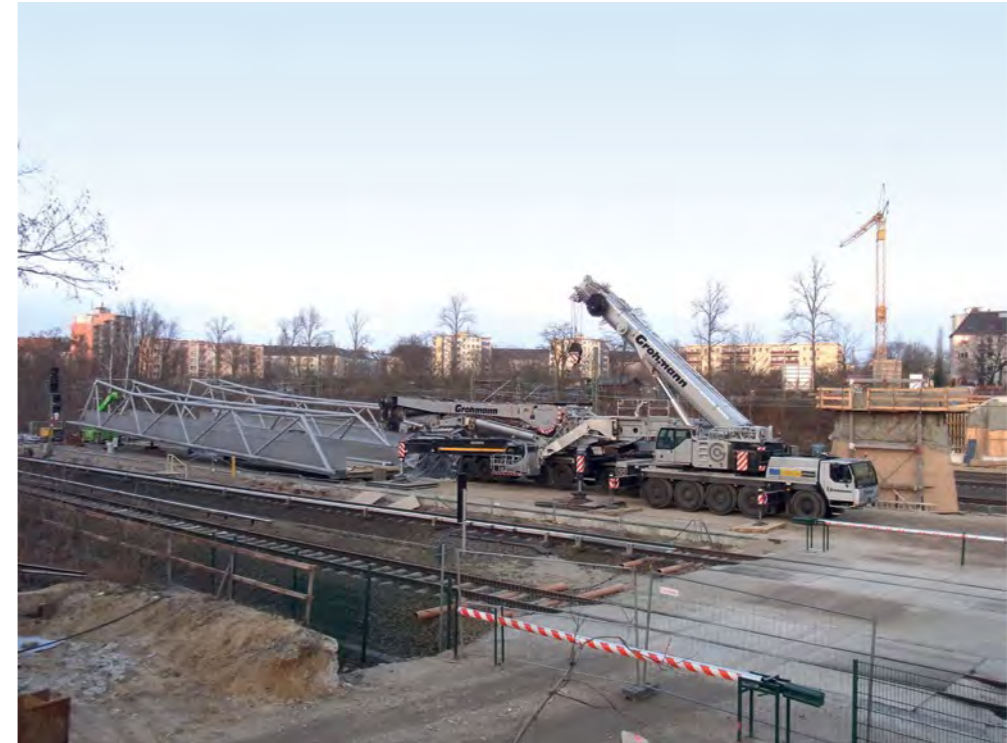
Die in zwei Teilen gefertigte Überführung vor dem Einbau, 22.3.2011
