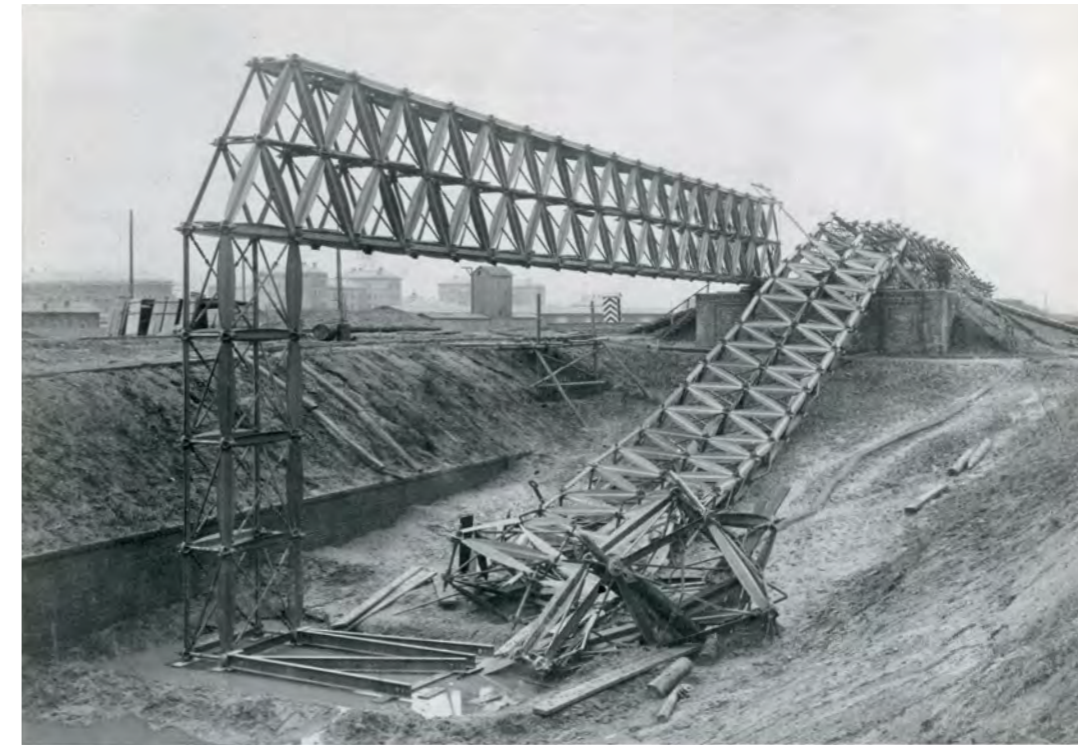
Die vom 2. Eisenbahnregiment auf dem Übungsplatz errichtete Kriegsbrücke, die wegen eines Materialfehlers einstürzte. Im Hintergrund die Kasernenbauten an der General-Pape-StraÙe, 1893
