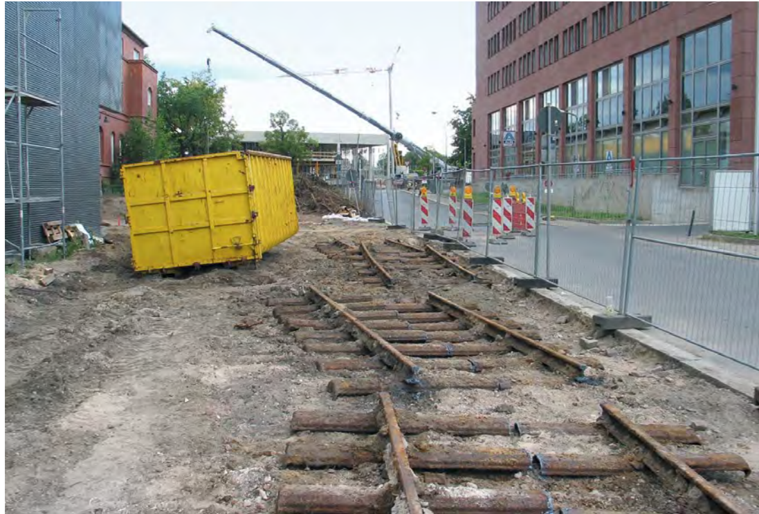
August 2009: Bei den Bauarbeiten zur Wilhelm-Kabus-Straße kommen Reste alter Schienen und Schwellen der Militäreisenbahn zum Vorschein.
