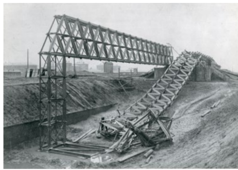
Die vom 2. Eisenbahnregiment auf dem Übungsplatz am Königsweg errichtete Kriegsbrücke, die wegen eines Materialfehlers einstürzte, 1893
