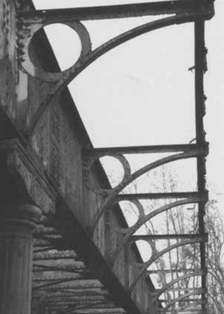
Konsolen des demontierten Laufstegs der Brücke 5, die zur Dresdner Bahn gehörte
