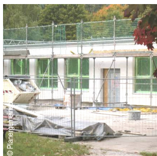
Energetische Sanierung Bauspielplatz
