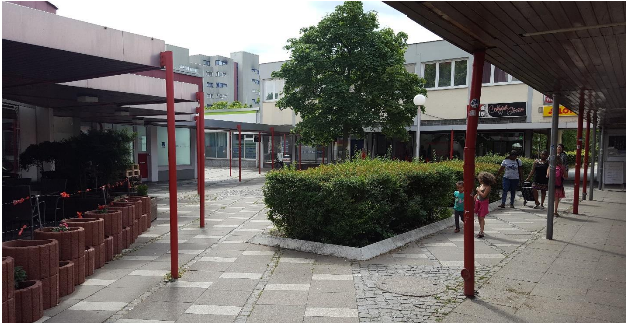
Abbildung 9 Blick in die Passage zwischen Nahkauf und Wohnturm westlich des Magistratswegs
