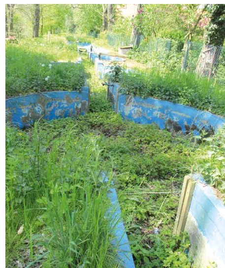
Alter Forellenhof wird abgerissen
