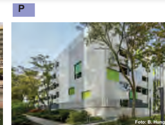
Berlin, Gropiusstadt: Sanierung Parkhaus
