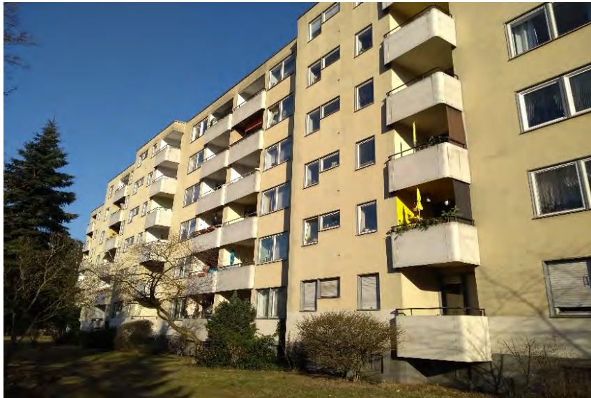
Unsanieretes großes Mehrfamilienhaus in Pillnitzer Weg
