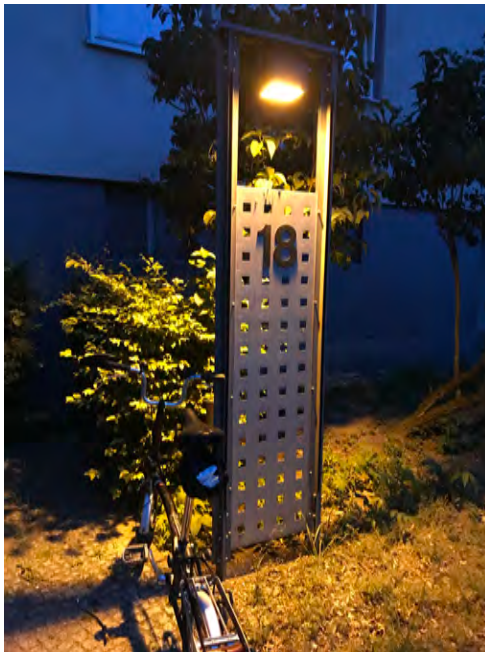
Nördlich des Pillnitzer Weges wurden die Lampen im Wohnhof erneuert.
