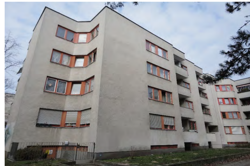
Abbildung 3.8: Unsaniertes großes Mehrfamilienhaus in der Heerstraße
