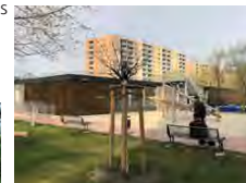
Beispiel Berlin Gropiusstadt: Umgestaltung Parkhaus (Dachfläche)
