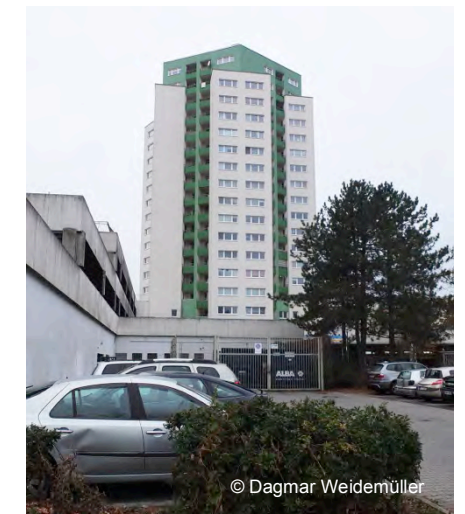
Die Parkhaus-Rückseiten sind in den Abendstunden unsichere Orte.
