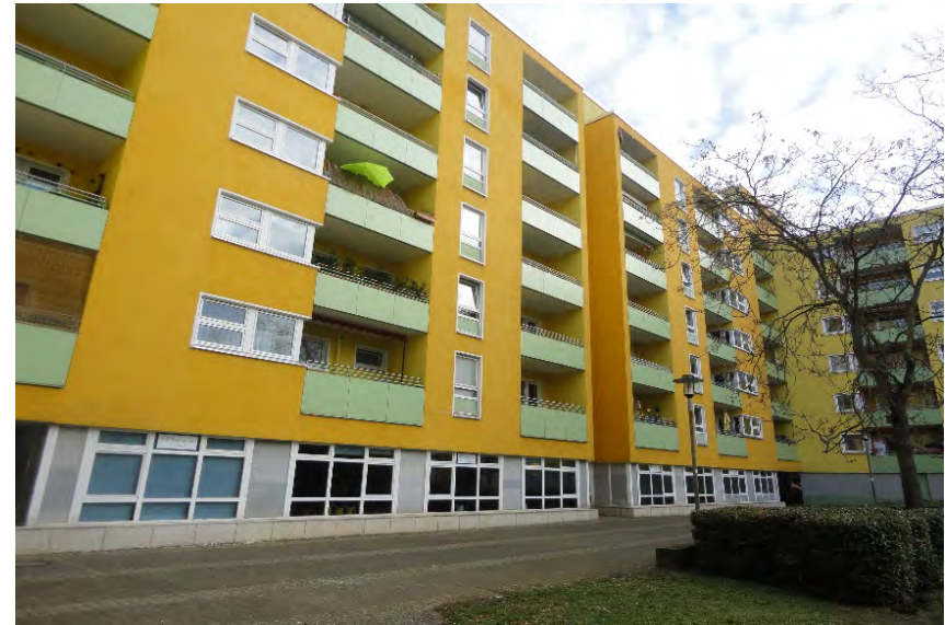
Sanieretes großes Mehrfamilienhaus in Obstallee
