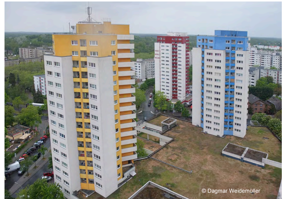
Abbildung 5.4 : Ortsteilzentrum: Dachfläche auf dem Staaken-Center – Potenzielle Fläche für ein ‚Begrüntes Dach‘
