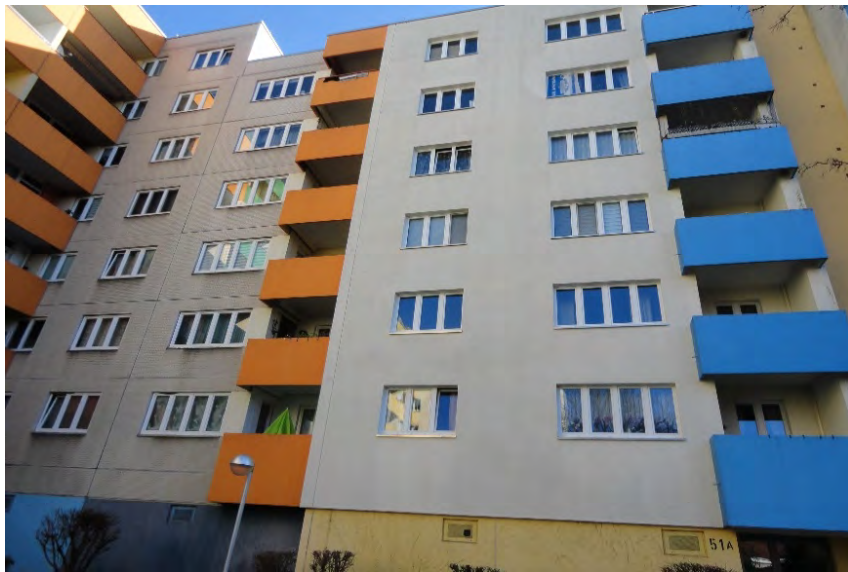
Teilsaniertes großes Mehrfamilienhaus in Maulbeerallee
