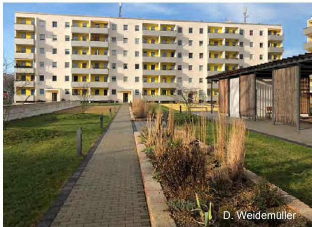
„Klotzcher Höfe“ in Dresden: Parallel zur Sanierung der Gebäude erfolgte die Neugestaltung der Wohnhof-Freiflächen: neue Wegebelege, schattenspendende Sitzbereiche (rechts im Bild), neue Außenbeleuchtung; Anpflanzen von klimaangepasster Vegetation.
