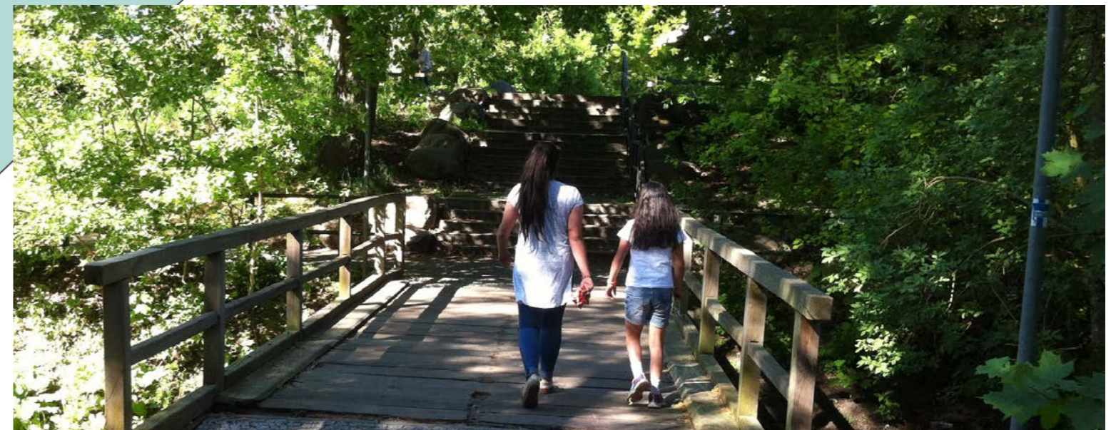
Zugang in den Park ist dunkel und unübersichtlich. Brücke ist marode.
