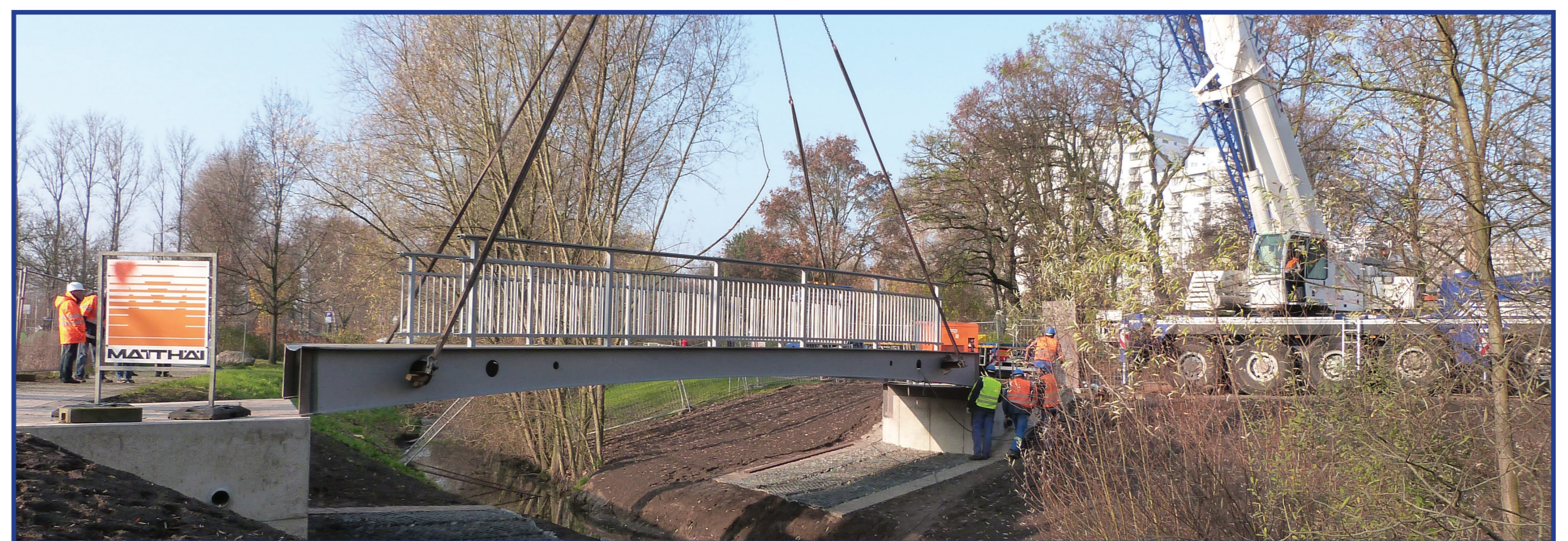
Der vorgefertigte Steg wurde Ende November mit Hilfe eines Krans eingesetzt.
