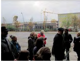
Im Bau befindliche Sporthallen gegenüber des Eingangs Kniprodestraße
