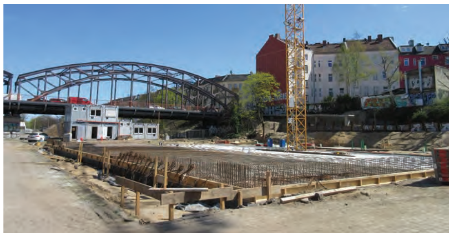
Bauarbeiten an der neuen Sporthalle im April 2016 © BSM mbH
