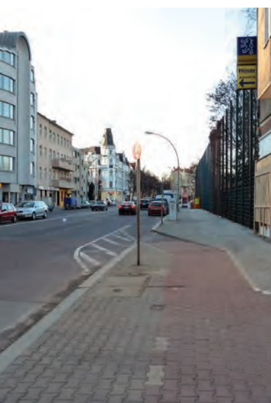
Mangelhafter Straßenraum Karl-Marx-Straße © BSM mbH
