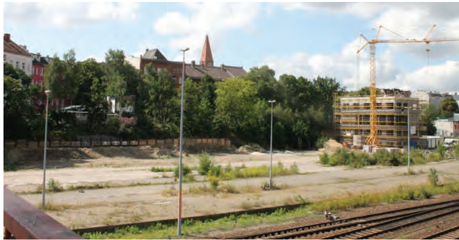
Das Gelände vor dem Bau der Schulsporthalle (im Hintergrund das Erweiterungsgebäude im Bau) © BSM mbH
