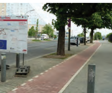
Erneuerung Gehweg Sonnenallee © BSM mbH
