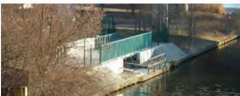
Erforderliche Brücke über ein Einlaufbauwerk © BSM mbH
