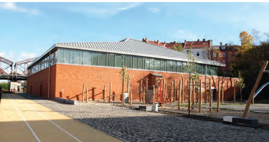
Die neue Schulsporthalle an der Hertabrücke © BSM mbH
