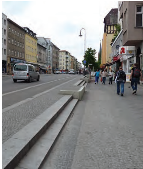
Südliche Karl-Marx-Straße nach dem Umbau © BSM mbH
