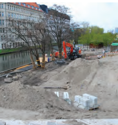
Bauarbeiten 2010 © Planergemeinschaft eG
