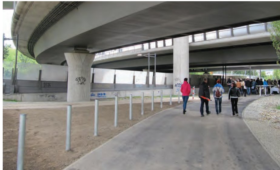
Die Wegeführung unter den Autobahnbrücken © BSM mbH
