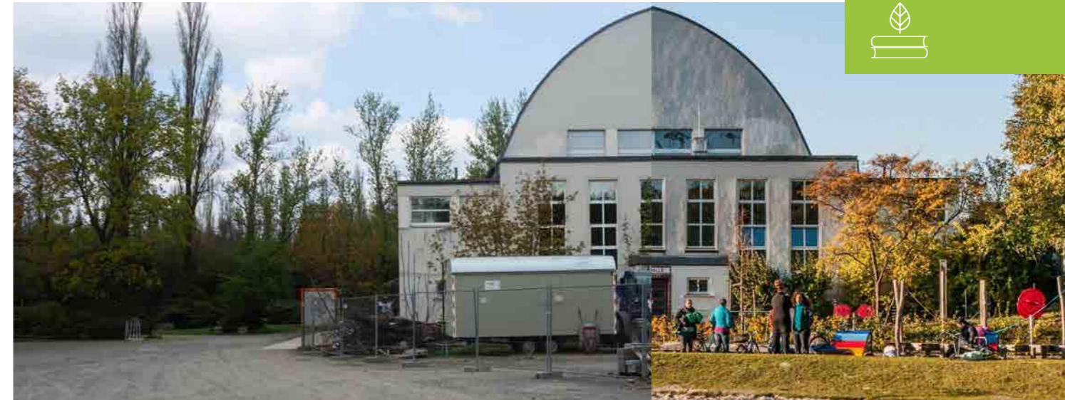
Abb. 16-17: Der Werferplatz vor und nach der Erneuerung
