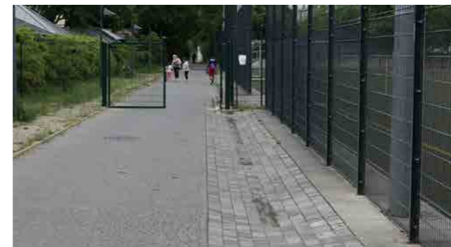
Abb. 29: Kleine Absenkungen neben einem Weg sind oft eingebaute Mulden zur Versickerung von Regenwasser, wie hier am Weg zwischen Freizeitbad Vabali Spa zum Tribünengebäude im Poststadion
