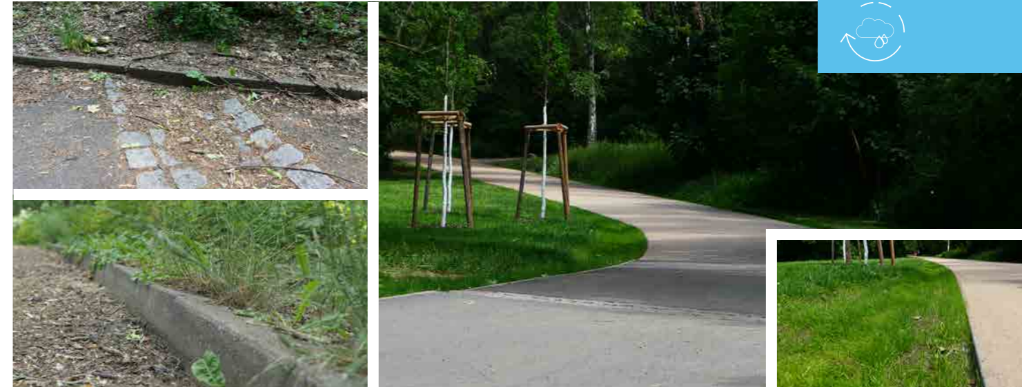
Abb. 25-28: Niederschlagswassermanagement im Fritz-Schloß-Park: Die Wegesituation vor (links) und nach der Baumaßnahme (rechts, rechts unten). Der helle Asphalt wurde übrigens ausgewählt, um die Aufheizung durch Sonneinstrahlung zu verringern.
