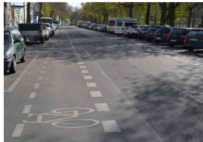
Abb. 44: Der neu angelegte Radweg in der Siemensstraße, inkl. Moabiter Kissen
