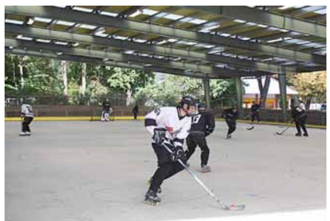
Nachher: Sanierte und überdachte Rollsportanlage, 2014 (Foto: Anka Stahl)
