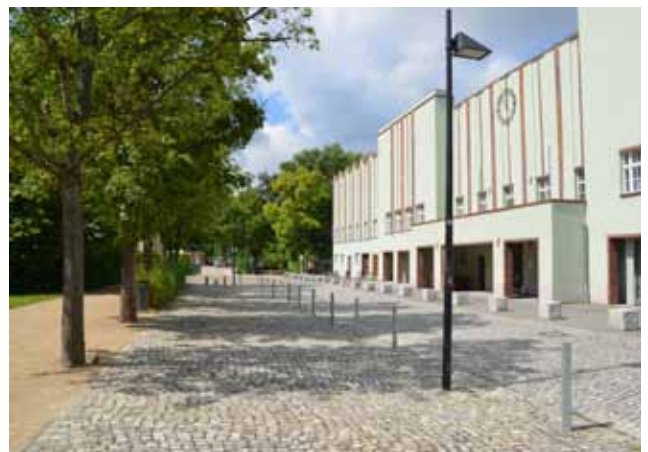
Nachher: Tribünengebäude und Vorplatz, 2015
