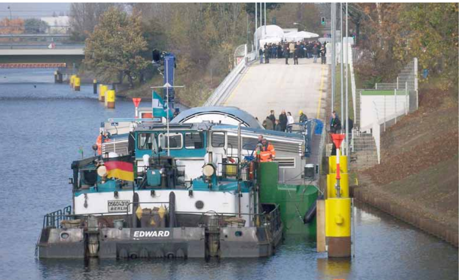
Fertiggestellte RoRo-Anlage, Neues Ufer, Gasturbinentransport
