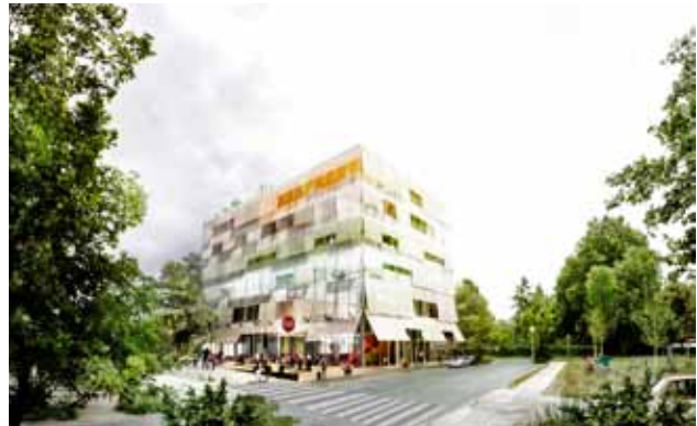
Geplante Baumaßnahme: Botschaft der Kinder, (Abbildung: ludloff + ludloff Architekten)
