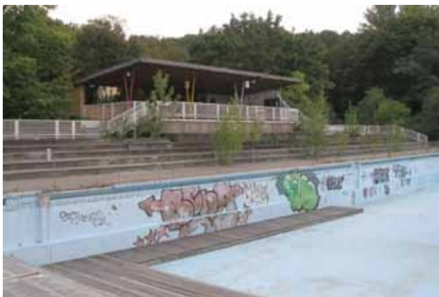
Vorher: marode Anlagen des geschlossenen Sommerbades, 2007
