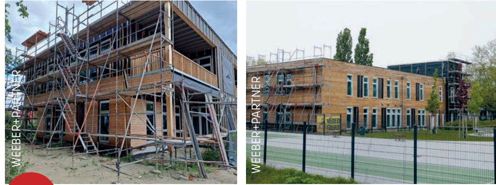
2 Kita Havelländer Ring 46: Neubau Kindertagesstätte (2021-2024) mit Fördermitteln der Nachhaltigen Erneuerung
