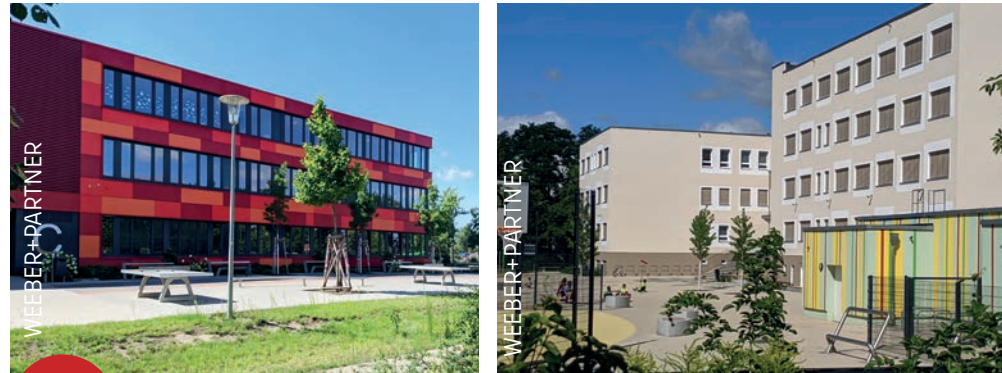
3 Pustelblume Grundschule: Neubau MEB (2012-2015) und Sanierung Hauptgebäude (2017-2019) mit Fördermitteln der Nachhaltigen Erneuerung
