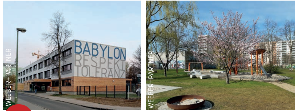
1 Haus Babylon: Gebäudeaufwertung (2018-2021) und Neugestaltung der Außenanlagen (2022-2024) mit Fördermitteln der Nachhaltigen Erneuerung
