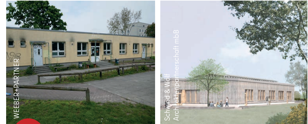
8 JFE SENFTE 10: Herstellung der Anschlussbedingungen und Anbau mit Fördermitteln vom Baufonds/Programm Sozialer Zusammenhalt und von Europa im Quartier (seit 2023)
