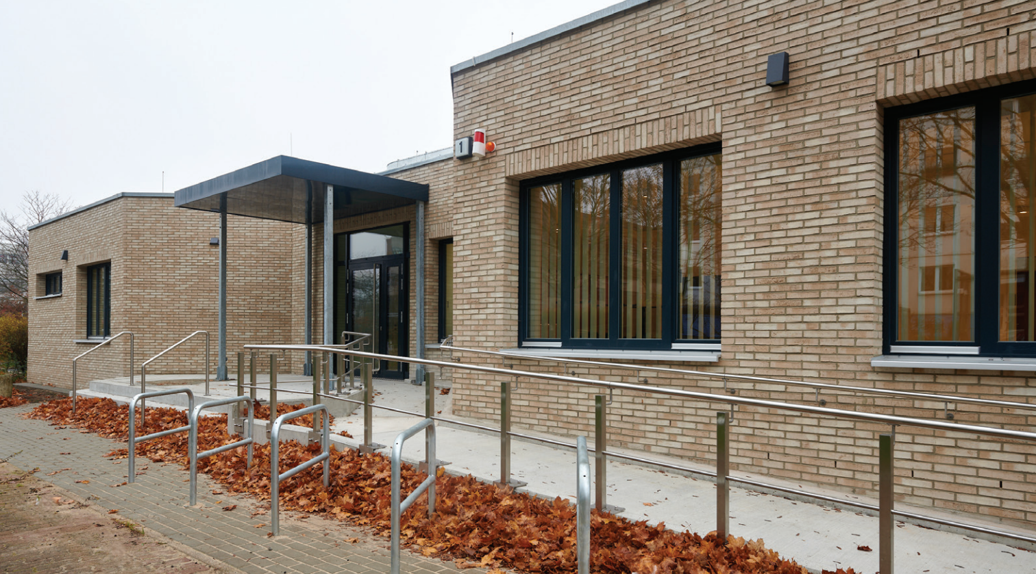
Rampe zu Haupteingang mit Vordach
