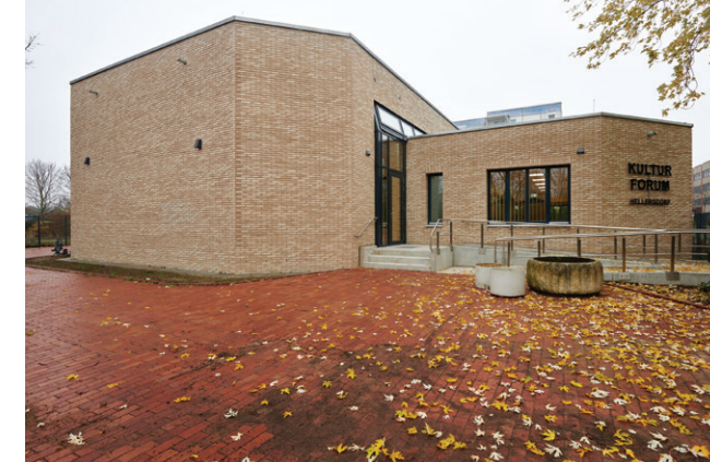
Notausgänge aus dem großen Saal in den Hof
