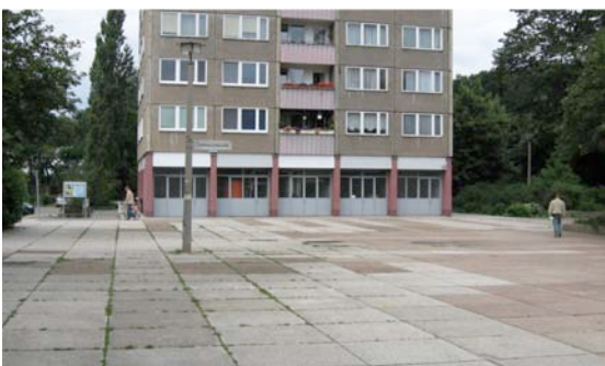
2. Bauabschnitt: Bereich vor dem Hochhaus an der Schwimmhalle
