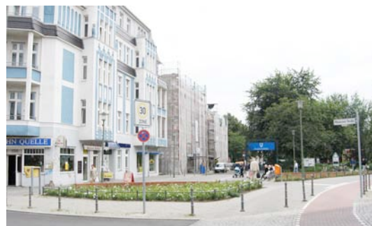
Sanierung der Gründerzeitsubstanz am U-Bahnhof
