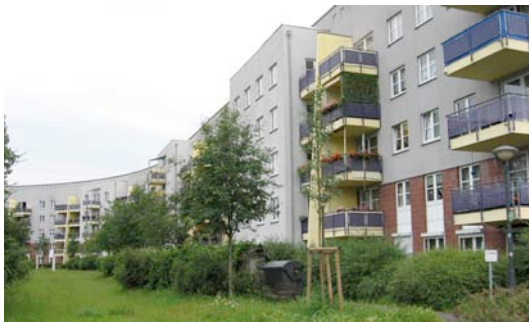
Gensinger Straße Wohnungsbau der 1990er Jahre
