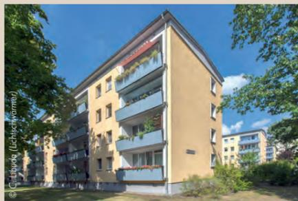
Der Bautyp QX wurde in Großblockbauweise - also noch nicht in Plattenbauweise - in Querwandbauweise mit Achsabständen zwischen 2,40 m und 3,60 m gebaut.
