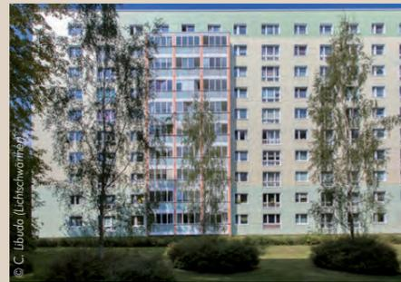
Mit der QP-Serie, eingeführt 1959, wurden erstmals in der DDR raumgroße Elemente verwendet, d.h. die Gebäude sind „Plattenbauten“ aus industrieller Fertigung. Es handelt sich um eine Querwandbauweise mit tragenden Innen- und Außenwänden. Die Giebelseiten wurden zum Teil offen mit Balkonen gebaut. Erstmals wurden Platten mit Schaumpolyesterkerndämmung und außenseitigen Keramikplatten verwendet.
