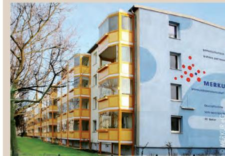
Mit Q3 begann 1957 die Serienproduktion der Großblockbauweise in Berlin. Es handelt sich per Definition noch nicht um „Plattenbau“, eine Wand bestand noch aus mehreren einzelnen Betonelementen.
