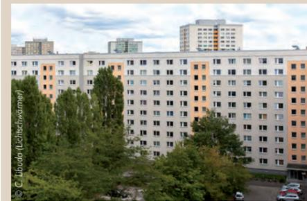
Beim QP wurden erstmals in der DDR raumgroße Elemente verwendet, d. h. die Gebäude sind „Plattenbauten“ aus industrieller Fertigung. Markant sind die außenseitig verwendeten Keramikplatten. Die beiden Gebäude Sewanstraße 173-179 und 209-219 werden seit Erstbezug als Studentenwohnheim genutzt und wurden auch zu diesem Zweck gebaut. Den privaten Zimmern sind gemeinschaftlich genutzte Küchen und Duscbäder zugeordnet. Einzelne Zimmer haben Zugang zu einem eigenen Balkon.
