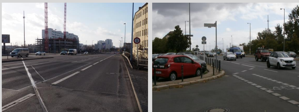
Abbildung 1.13: fehlender straßenbegleitender Fußweg in der Frankfurter Allee (links Blick von der Bushaltestelle Lichtenberger Brücke, rechts Blick von der Hubertusstraße)
