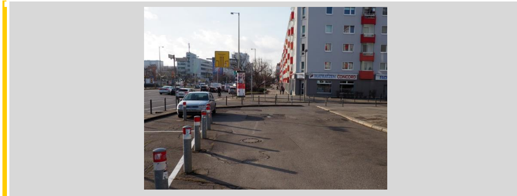
Abbildung 2.6: hoher Bordstein am Knotenpunkt Alte Frankfurter Allee / Hubertusstraße
