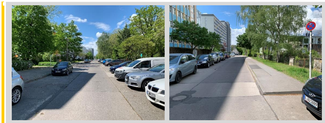
Abbildung 1.11: fehlender straßenbegleitender Fußweg in der Gotlindestraße (links Straßenabschnitt ohne nördlichen Gehweg, rechts Ende des straßenbegleitenden Gehwegs am Friedhof)
