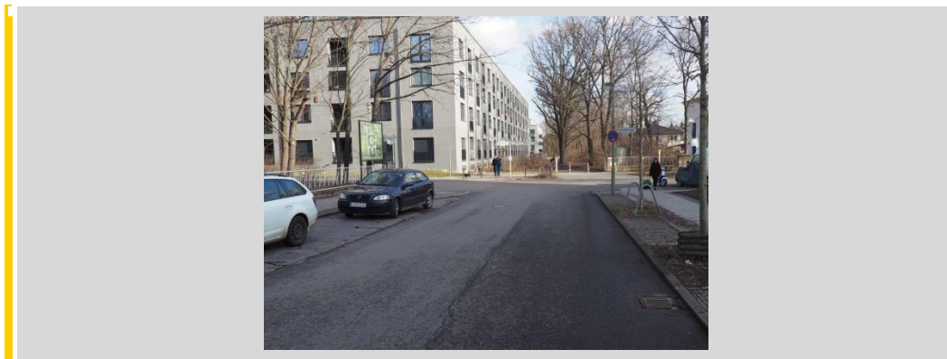
Abbildung 4.16: Knotenpunkt Gotlindestraße / Klara-Weyl-Straße – Kriemhildstraße (Blickrichtung aus Gotlindestraße)
