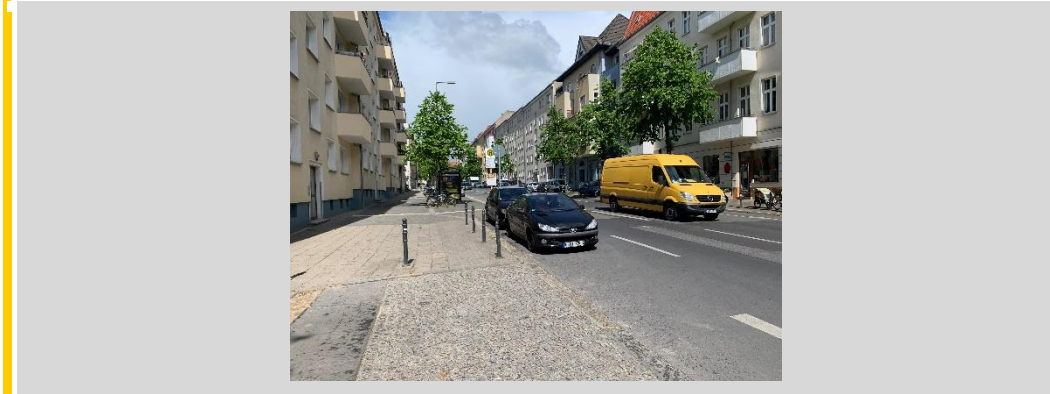
Abbildung 2.14: fehlende Radverkehrsanlage in der Knotenpunktzufahrt in der Alfredstraße
