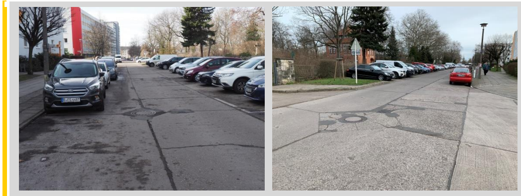
Abbildung 2.2: Straßenoberfläche der Gotlindestraße
