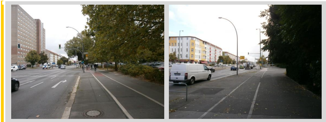
Abbildung 2.8: zu schmaler Radweg in der Frankfurter Allee, südliche Straßenseite
