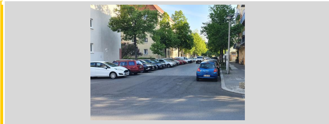
Abbildung 1.22: fehlender barrierefreier Übergang am Knotenpunkt Fanningerstraße/Hubertusstraße
