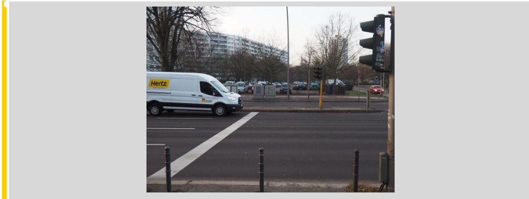
Abbildung 1.8: fehlende Fußgängerfurt am östlichen Knotenarm des Knotenpunktes Frankfurter Allee / Ruschestraße
