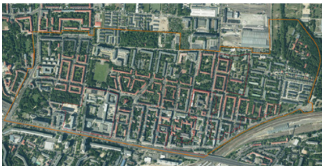
© Geoportal Berlin: Luftbild des Sanierungsgebiets Frankfurter Allee Nord | 2015
