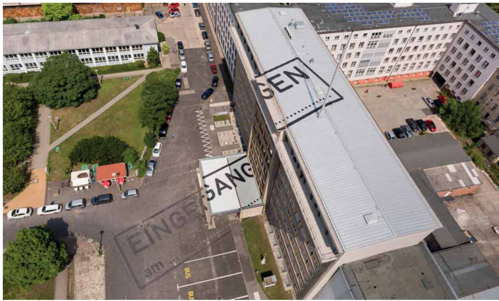
Haus 1 | Kunst am Bau
