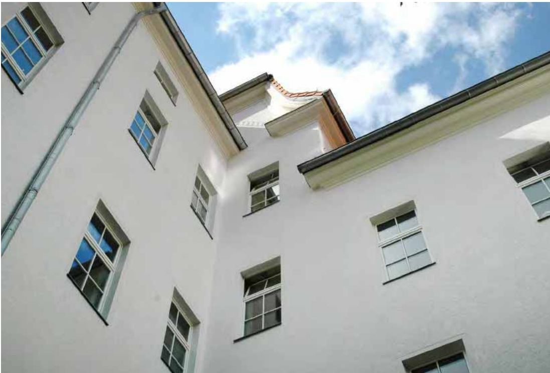
Dathe-Gymnasium Helsingforser Straße 11 - 13
