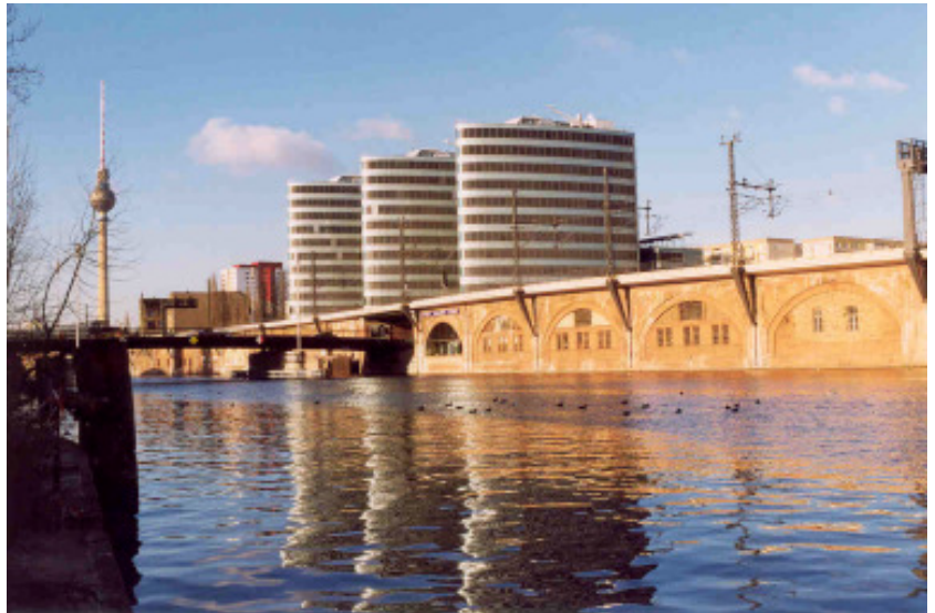
Büro- und Geschäfts- haus 'Trias' in Mitte
