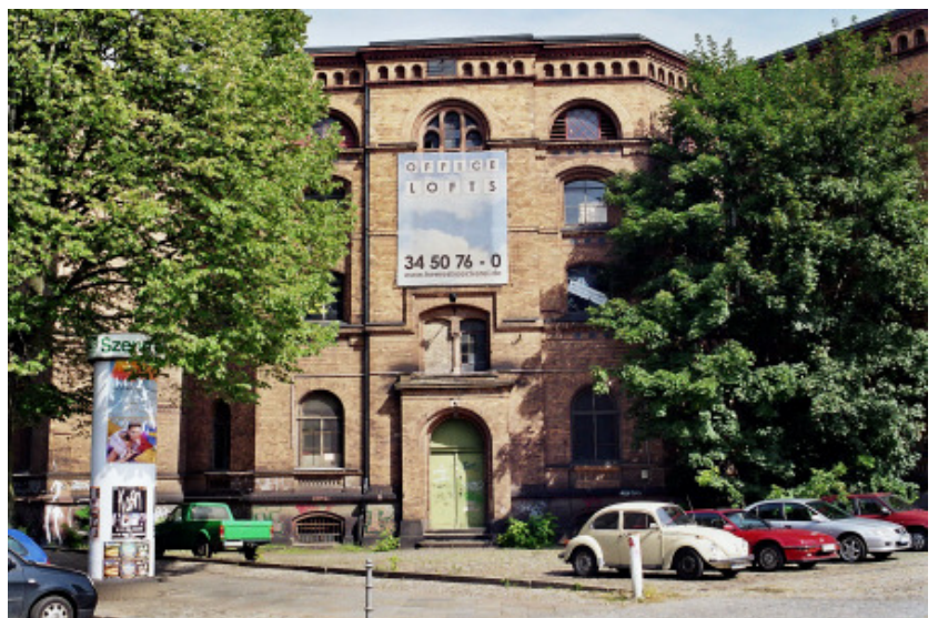
Ehem. Heeresbäcke- rei (hier das Back- haus) an der Brom- mystraße
