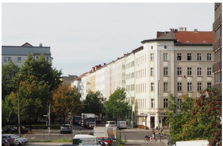
Erhaltene Blockrand- bebauung an der Friedrichsberger Straße
