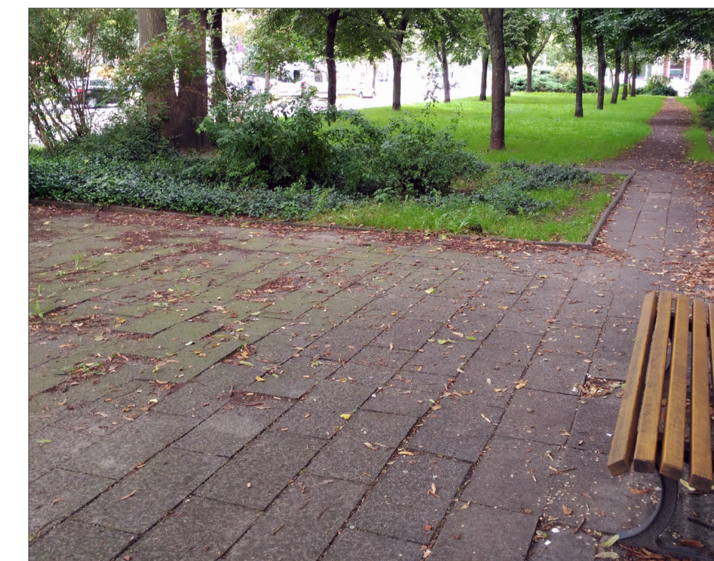
seitlicher Aufenthaltsbereich - August 2017
