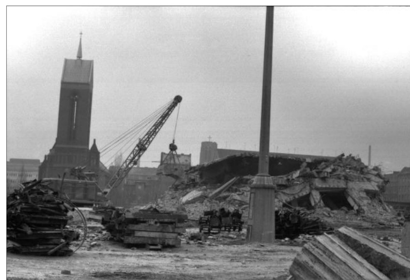
Abbruch der Sporthalle - 1971
