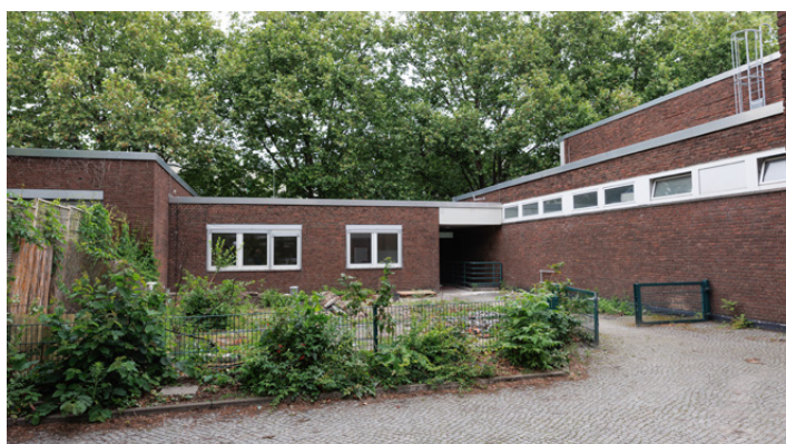
Die Hausmeisterwohnung wird durch einen Holzneubau ersetzt und genau zwischen dem Haus 7 und der Sporthalle eingepasst.
