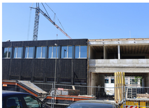
An der Feuerwache sind ersten Fassadenteile erkennbar. Sie wurden im Werk vorgefertigt.
