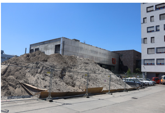
Neben dem Hochhaus wird die Leitstelle der Berliner Feuerwehr erweitert.
