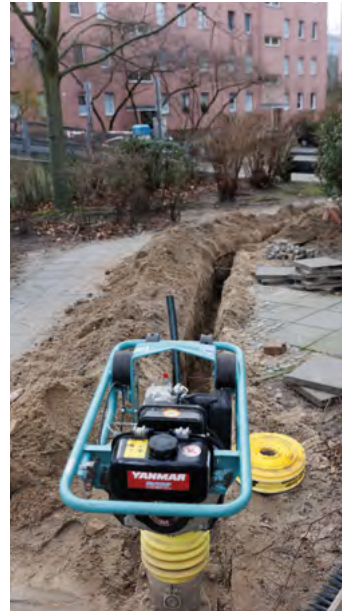
Kabelverlegung in der Paul-Hertz-Siedlung
