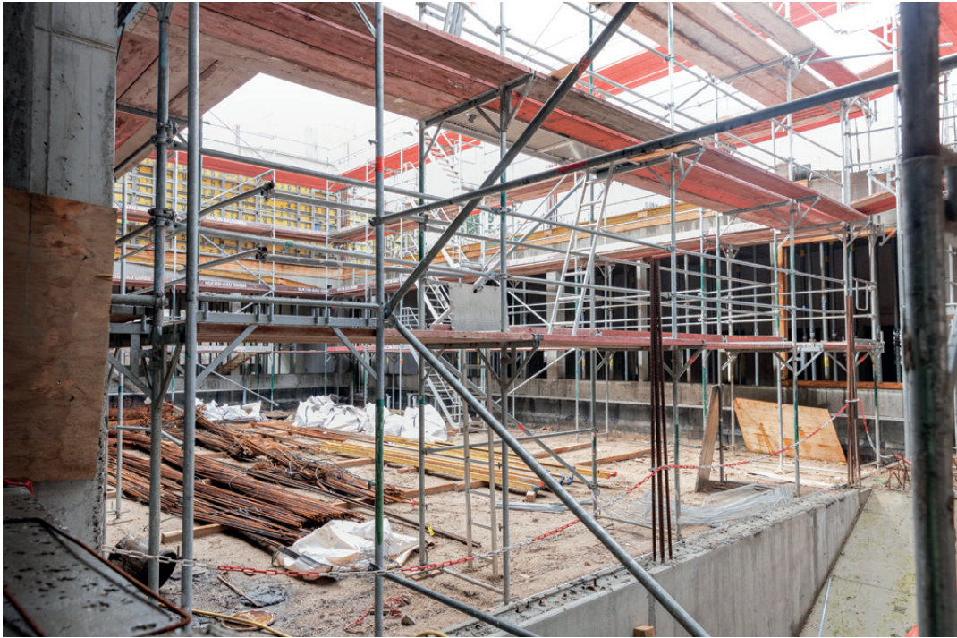
Blick in einen der Lichthöfe im Rohbau des Oberstufenzentrums
