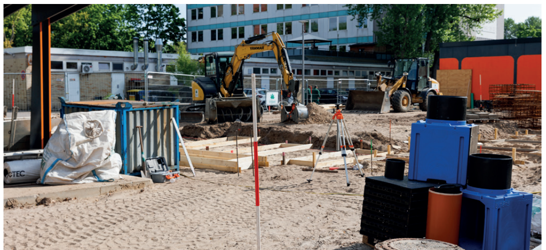
Am 3. Bauabschnitt des Grünzuges gehen die Arbeiten voran. Zwischen den beiden Ausgängen des U-Bhf. Halemweg werden derzeit die Fundamente für den Ballfang-Zaun gesetzt und die Rigolen (rechts im Bild) für das Regenwasser in den Boden versenkt.
