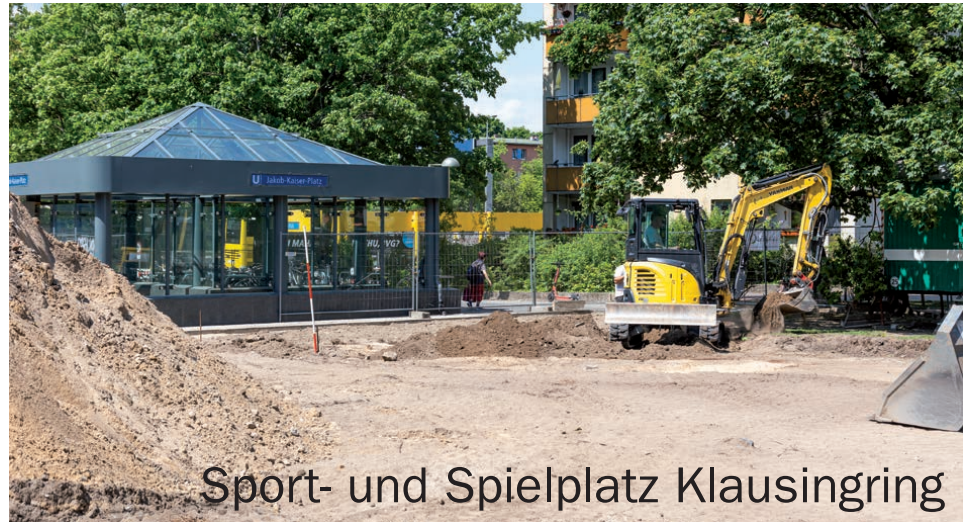
Zunächst wird alter Asphalt und Beton am U-Bhf. Jakob-Kaiser-Platz beseitigt
