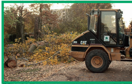
Baubeginn am Popitzweg, Nov. 2020
