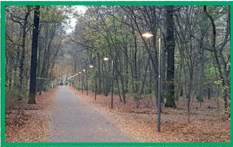
Inbetriebnahme von Laternen, Okt. 2020
