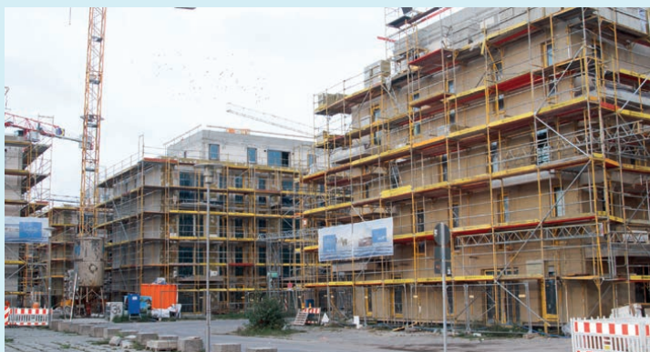
Großbaustelle östliche Wasserstadt Spandau: hier an der Daumstraße
