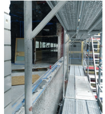
Blick aus dem Klassenraum auf die Baustelle Poelchau-Schule
