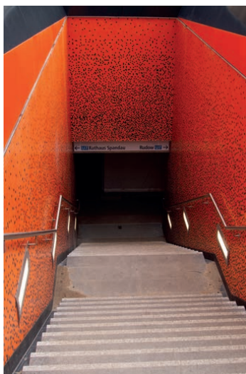
Leuchtend Orange: der 2. Ausgang am U-Bhf. Halemweg ist seit Februar geöffnet. Die Sanierung des Bahnhofes kommt gut voran und soll Ende 2020 fertig sein.
