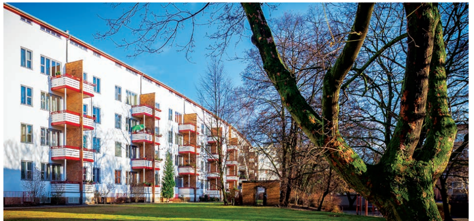
Otto Bartning, „Langer Jammer“ an der Goebelstraße, Südseite, erbaut 1930
