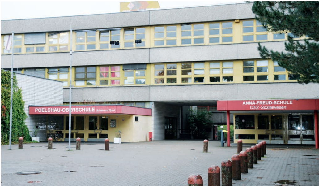
Der linke Teil des Gebäudes, die ehemalige Poelchau-Oberschule, wird 2019 abgerissen.
